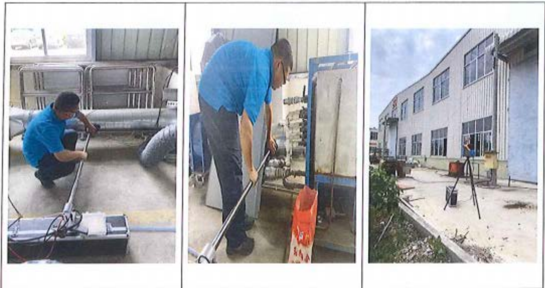
焊接废气排气筒 1#处理前
